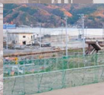
▲大船渡小学校2階から見渡した周囲の様子
